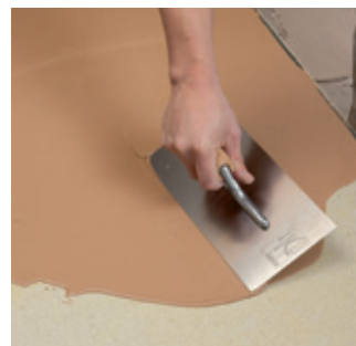
3. Na pripravený podklad nalejte rýchlu nivelačnú hmotu SL 52 pokiaľ možno v jednom pracovnom kroku v požadovanej hrúbke vrstvy (max. hrúbka = 20 mm) a rovnomerne rozotrite stierkou.
