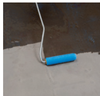
2. Nasiakavý podklad rovnomerne napenetríte s Hĺbkový základ D7
