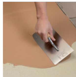
3. Na pripravený podklad nalejte rýchlu nivelačnú hmotu SL 52 pokiaľ možno v jednom pracovnom kroku v požadovanej hrúbke vrstvy (max. 20 mm) a rovnomerne rozotrite stierkou.
